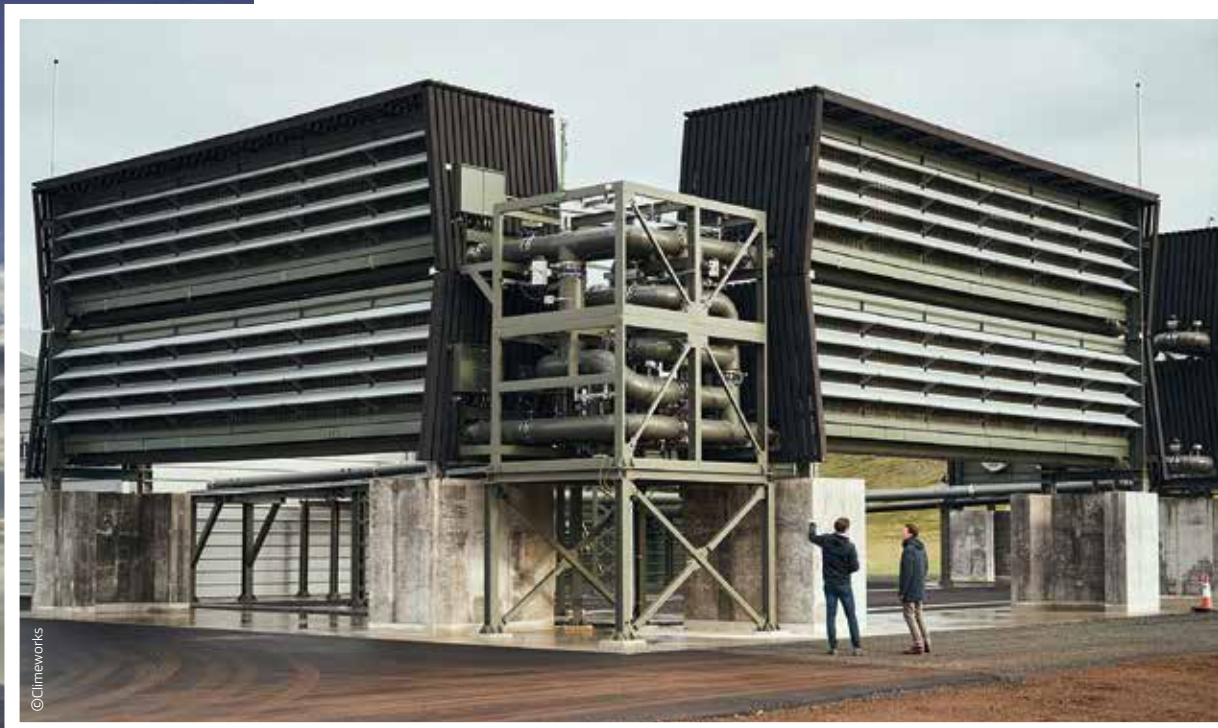
클라임웍스의 DAC 모듈 오르카(위)는 헬리세이다 지열 발전소에서 공급하는 재생 에너지를 이용해 대기 중의 탄소를 직접 포집한다. 수증기를 내놓고 있는 아이슬란드 헬리세이다 지열 발전소(왼쪽).
