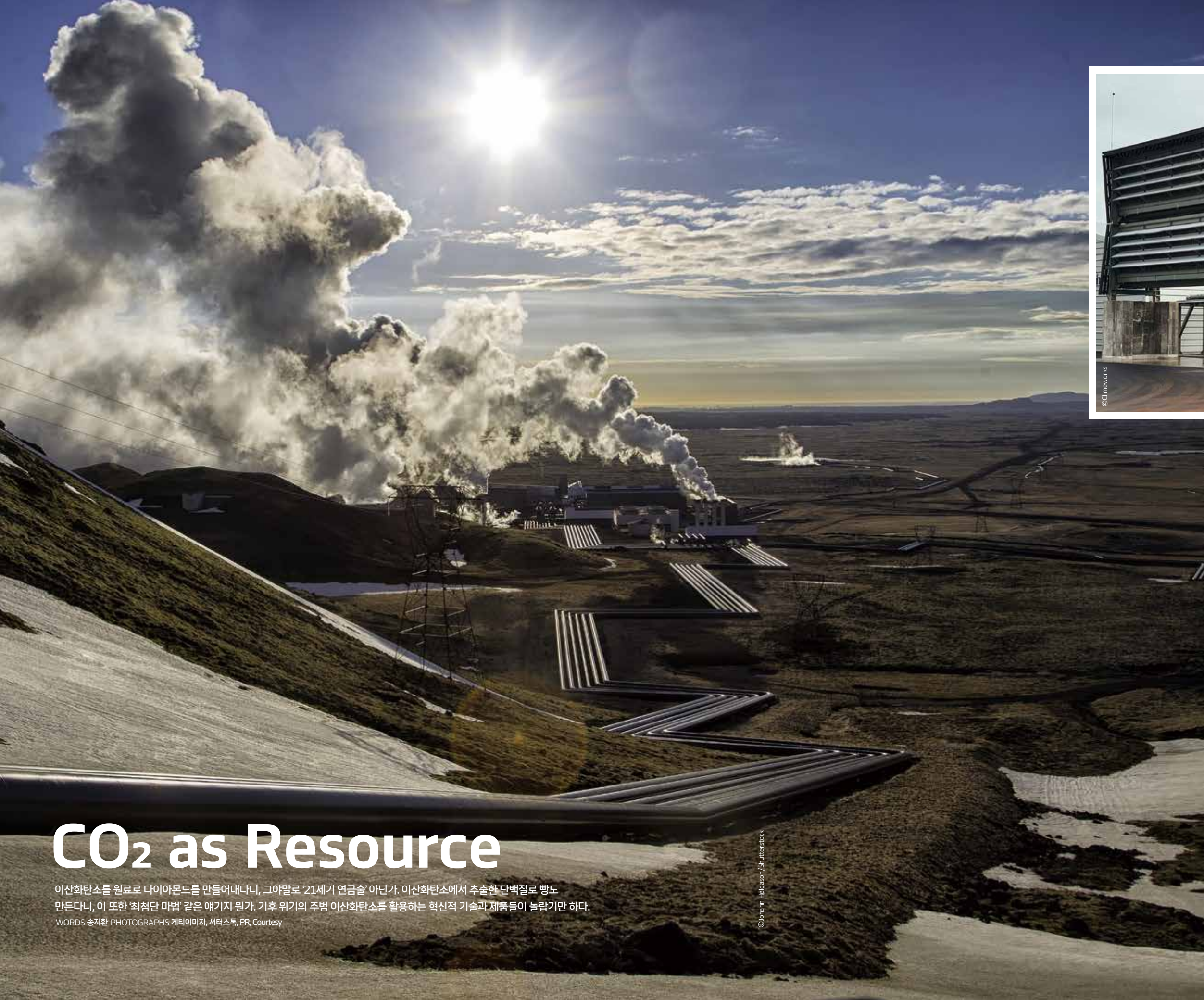
클라임웍스의 DAC 모듈 오르카(위)는 헬리세이다 지열 발전소에서 공급하는 재생 에너지를 이용해 대기 중의 탄소를 직접 포집한다. 수증기를 내놓고 있는 아이슬란드 헬리세이다 지열 발전소(왼쪽).
