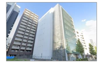
Japonská technická kancelář
